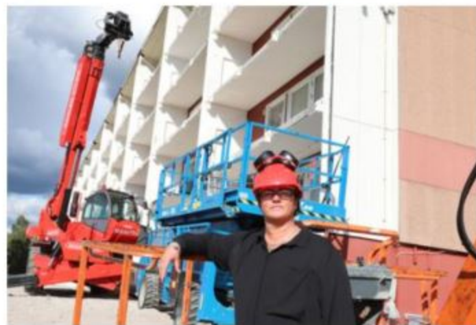
Styreleder Mona Anita Waleur i Greåkerdalen I Borettslag gleder seg over at arbeidene med nye balkonger er i full gang. – Dette er en god investering både i livskvalitet og økt verdi for leilighetene, sier hun.
